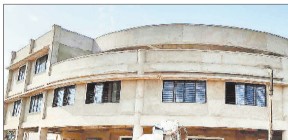
निर्माणाधीन प्रशासनिक भवन।
